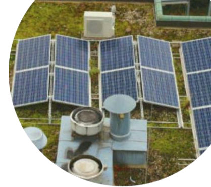
Abbildung 3: EnBW, Photovoltaik auf begrütem Flachdach.
